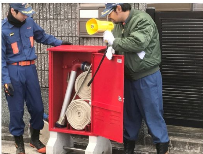
消火栓ボックスの中身の説明
